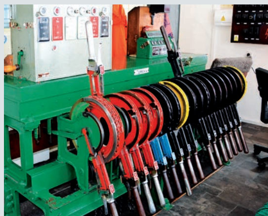
Výhybkářský přístroj na stavědle St. 1
